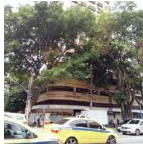
Fachada do edifício
